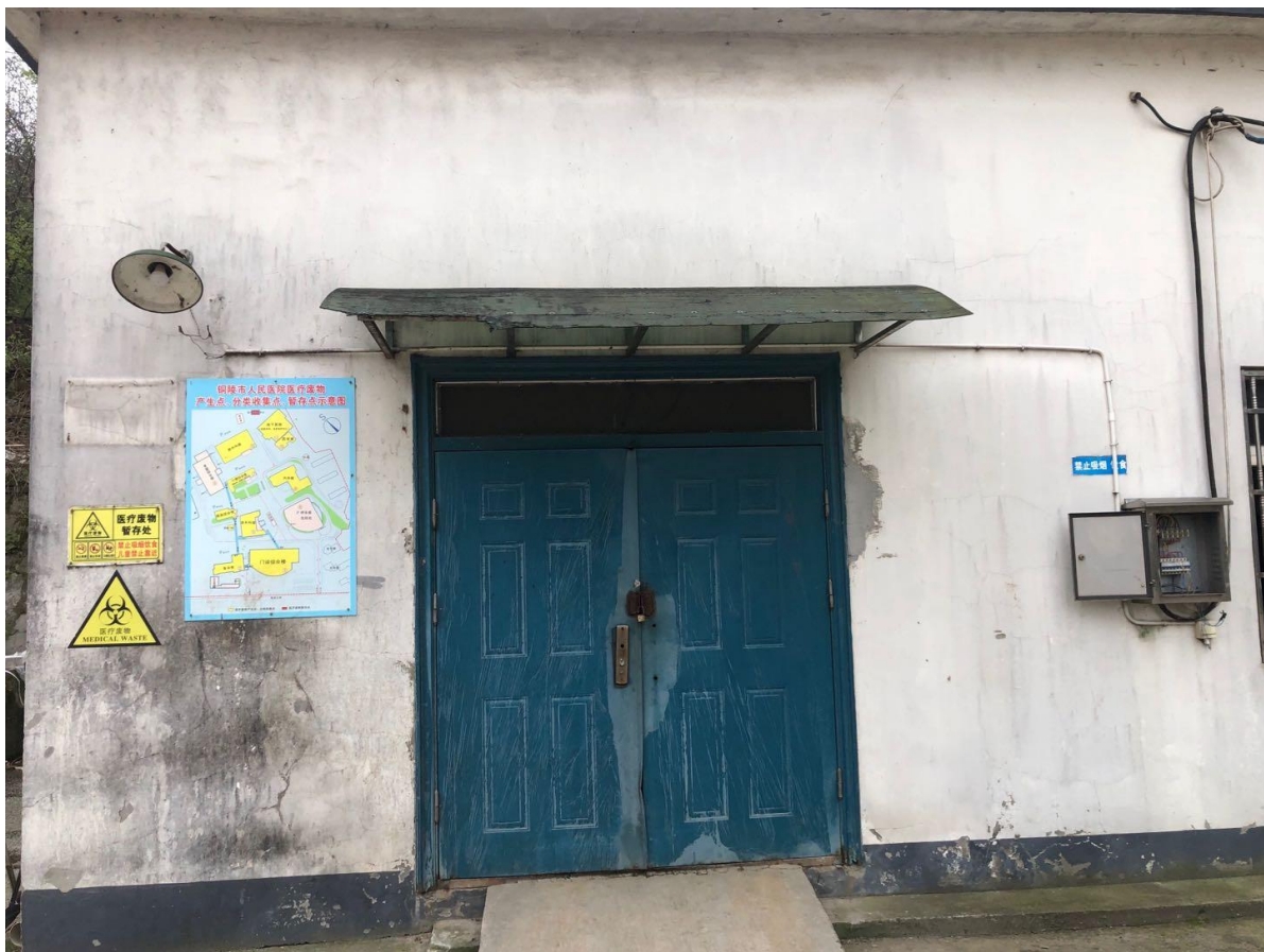
图 4-5 铜陵市人民医院医疗废物暂存间
