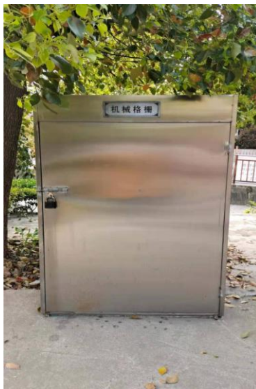
图 4-5 铜陵市人民医院污水处理站格栅机加盖密封
