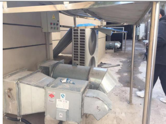
直线加速器机房楼上排风口
