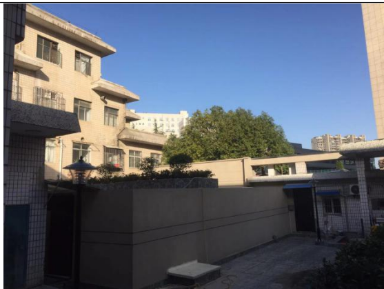
直线加速器机房楼上
